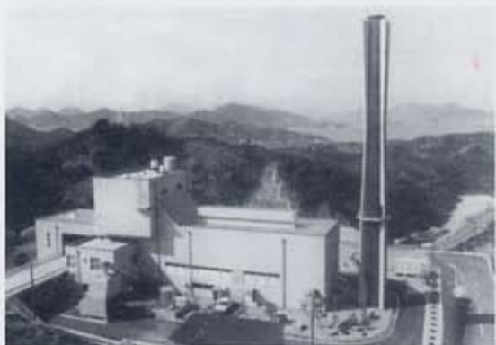
▲1981（昭和56）年、向島町クリーンセンターが完成。可燃物焼却処理工場には、公害対策として電気集塵器を設置した。
