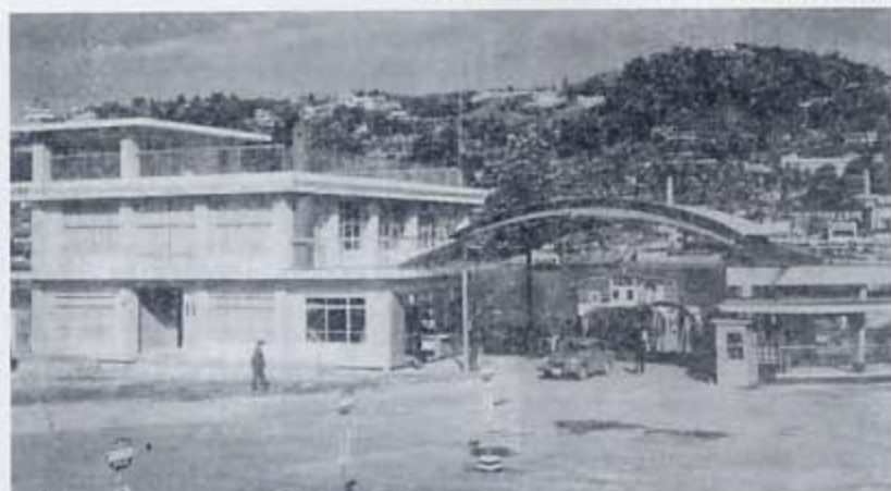
▼1964（昭和39）年、公営渡船の事務所が完成。
