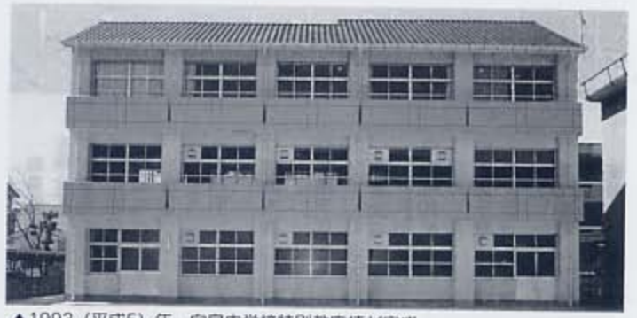
▲1993(平成5)年、向島中学校特別教室棟が完成。
