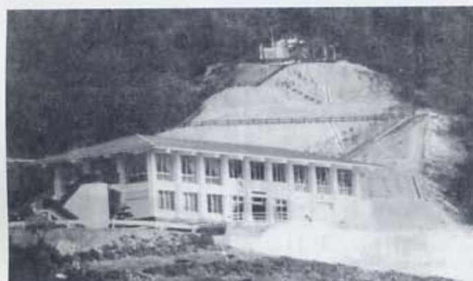
▲1984（昭和59）年、農業構造改善事業により整備してきた、立花自然活用村の郷土文化保存伝習施設兼管理センター・野外緑地広場・駐車場等が完成。
