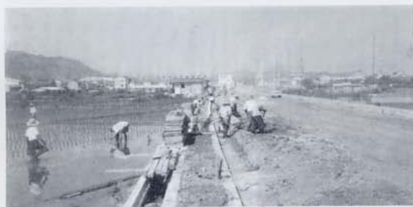
◀ 1969（昭和44）年、田尻から川尻バス車庫前までの道路舗装工事の様子。左側には田んぼが見える。向島で稲作が行われていたことを知る人も、だんだん少なくなってきた。
