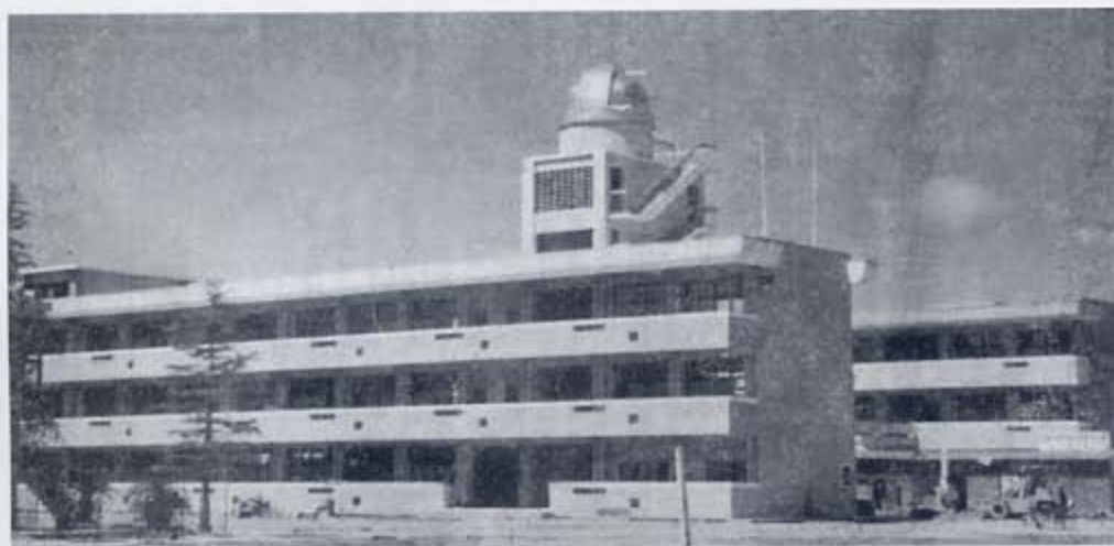
◀ 1965（昭和40）年、 向島中学校校舎が完成。
