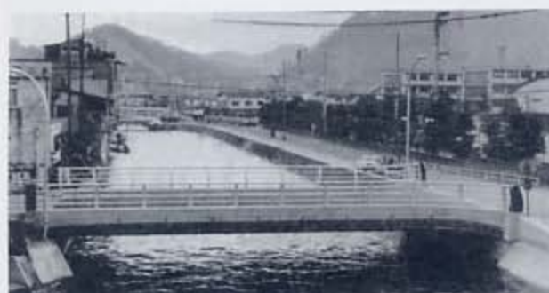
▲ 1980（昭和55）年、小歌島橋が完成。車道幅員6.5メートル、歩道幅員1.5メートル。
