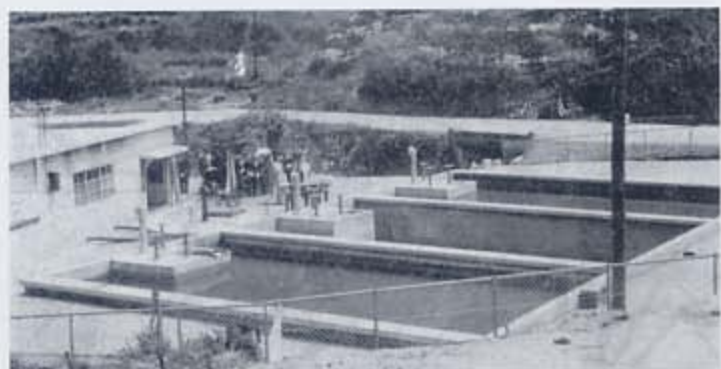
▲1965（昭和40）年、 最大ろ過能力550トン／日の浄水場が、新たに川尻地区に完成。
