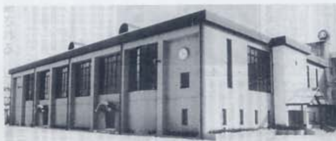
▲1984（昭和59）年、旧講堂を改築し、向島中央小学校屋内運動場が完成。
