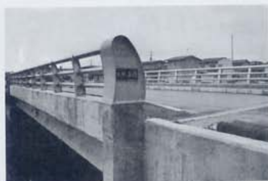
▲1976（昭和51）年、富浜地区・有井地区の急激な宅地化・工業化による交通の混乱を避けるため、西富浜と中富浜をつなぐ九軒島橋が完成。
