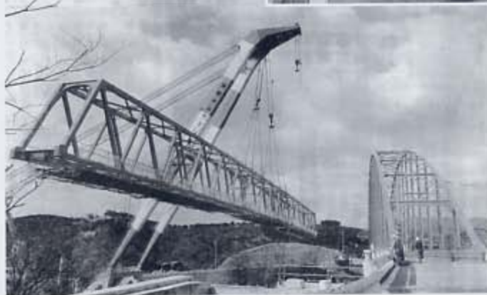
1990(平成2)年、向島大橋連絡歩道橋が完成。三幸小学校鼓笛隊を先頭に約300名が渡り初めをした(写真右)。写真下は、ワーレントラス橋を300トン型起重機船で吊り上げている様子。
