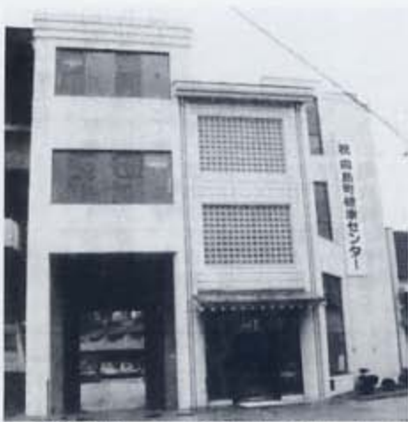
▲1986（昭和61）年、向島町健康センターが完成。
