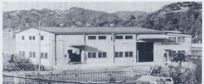
▲1985（昭和60）年、岩子島農産物集出荷施設が完成。
