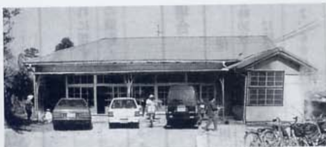
▲1990（平成2）年、旧歌島中央保育所跡地に共同作業所が開所。
