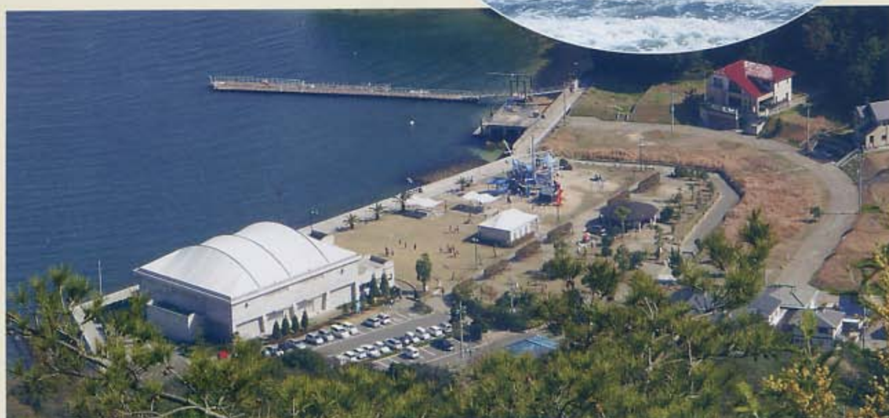
▲向島町マリユースセンター
