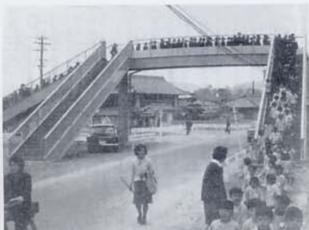
▲1969（昭和44）年、向島中央小学校北側に歩道橋が完成。写真は4月21日の渡り初め式の様子。
