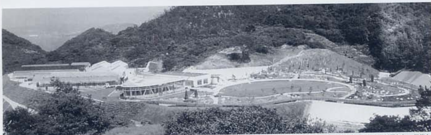
▲1995（平成7）年、フラットスラブ工法による展示室、芝生広場、育苗施設等を有する、向島洋らんセンターが完成。11月1日に竣工式が行われ、午後から一般公開された。
