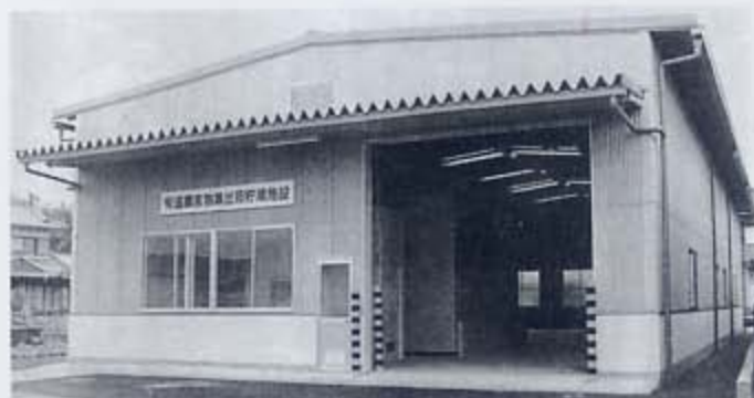
▲1990(平成2)年、有道農産物集出荷貯蔵施設が完成。
