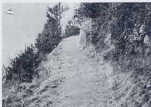
▲1974 (昭和49)年、高見山遊歩道 (展望台～立花地区) が完成。
