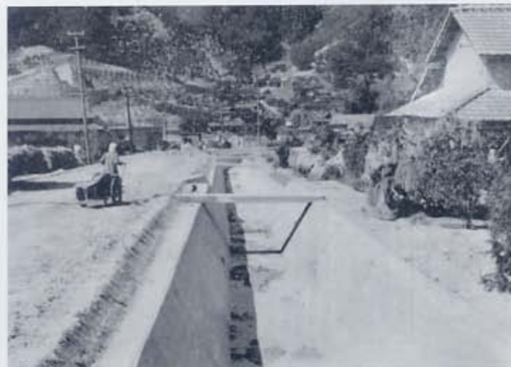
▲1966（昭和41）年、江尻川砂防工事が完成。
